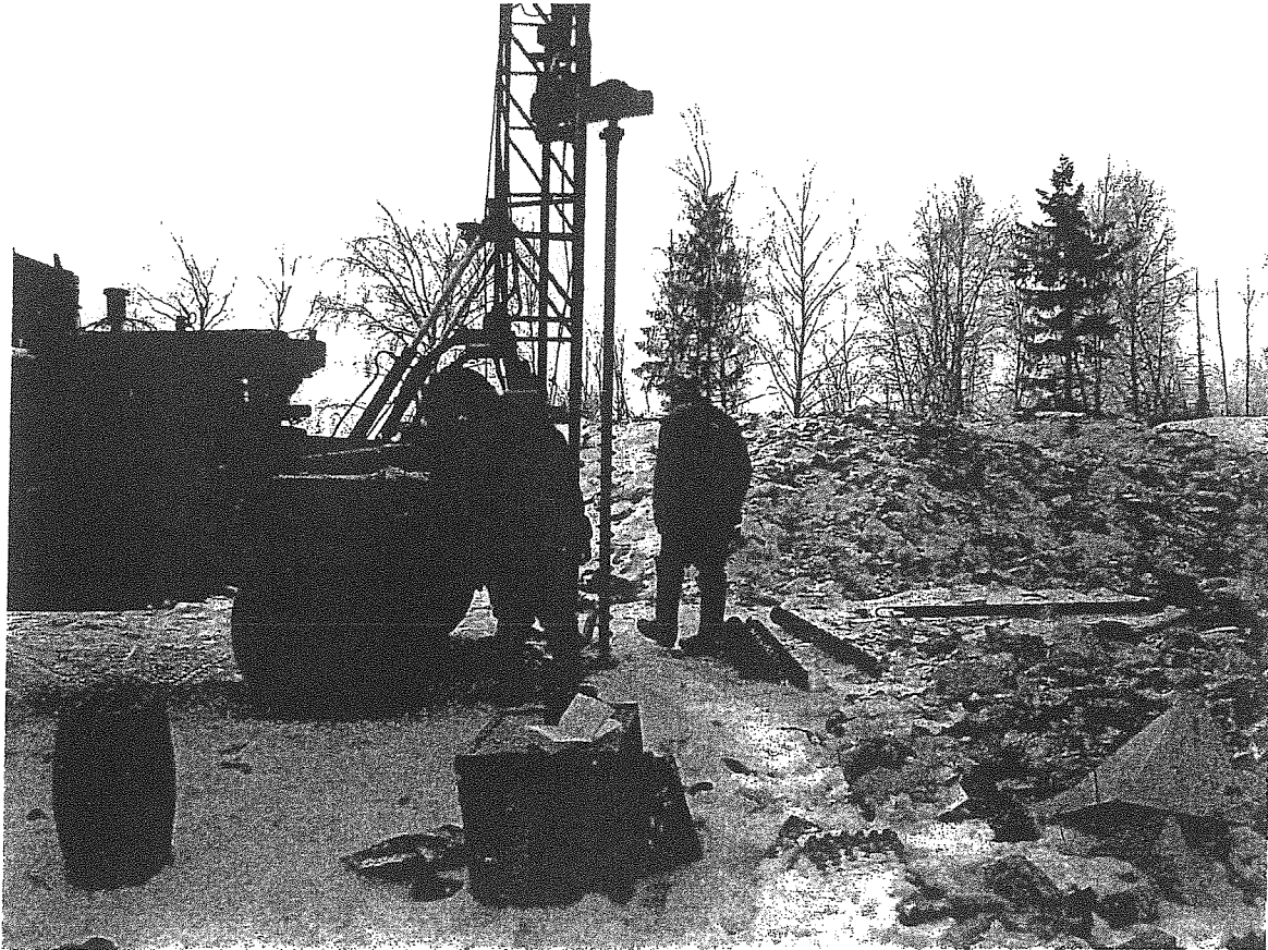
Фото 1. Бурение скважины № 1-Р
